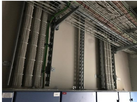
Figur 9: Hyppigst anvendte oplægningsmetoder for kabler i føringsveje
